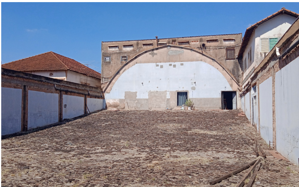
Salão do Cine Canaã. No prédio da antiga administração do cinema, percebe-se a marca da cobertura em arco. O piso está completamente deteriorado. Imagem: Autor
